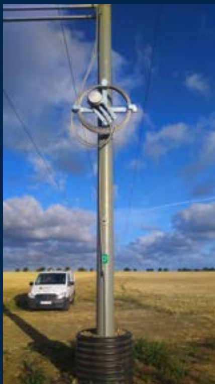
Luftoptokabel i södra Skåne installerad för ett av Sveriges största kraftbolags räkning
