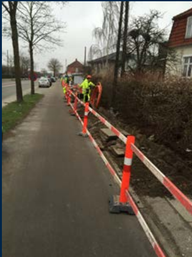
Fiberbyggnation i Köpenhamn för TDCs räkning
